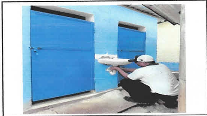
Foto 3: Mantenimiento de 3 baños y un lavamanos.
