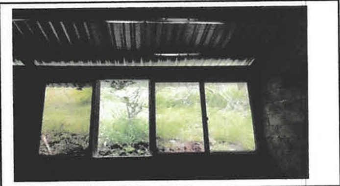
Foto 2: Instalación de ventanas de PVC.
